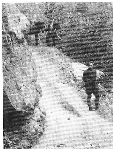
Участок дороги между с. Хамышки и Гузериплем перед началом реконструкции. 1928 г. Фото И. Башилова
