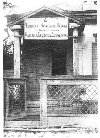
Здание управления начальника охраны Кавказского заповедника в Псебае. 1930 г. Фото И. Макаровского
