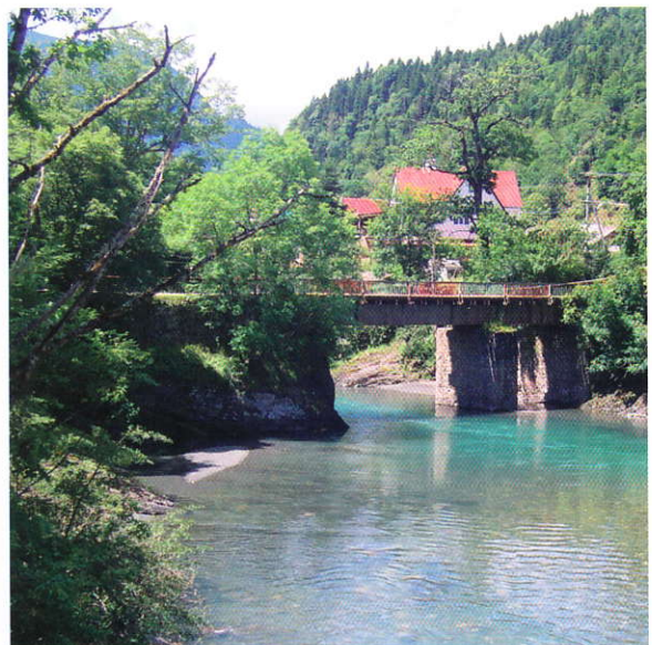
Мост через реку Белую в поселке Гузерипль
