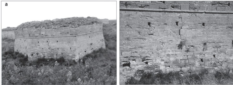
Рис. 4. Арабатская крепость (а) и дислокация в ее юго-восточной стенке (б).
