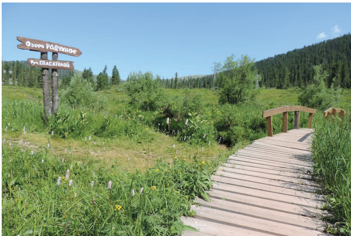
Рисунок 1 – Полотно тропы с настилом из поперечных досок перед мостиком через ручей Спасателей
