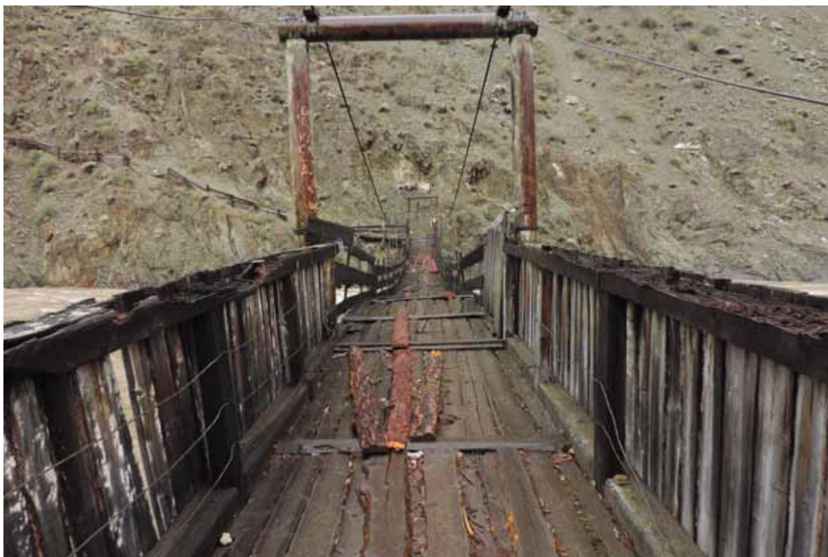
Рисунок 3 – Мост через р. Хемчик (состояние на конец июля 2018 г.)
