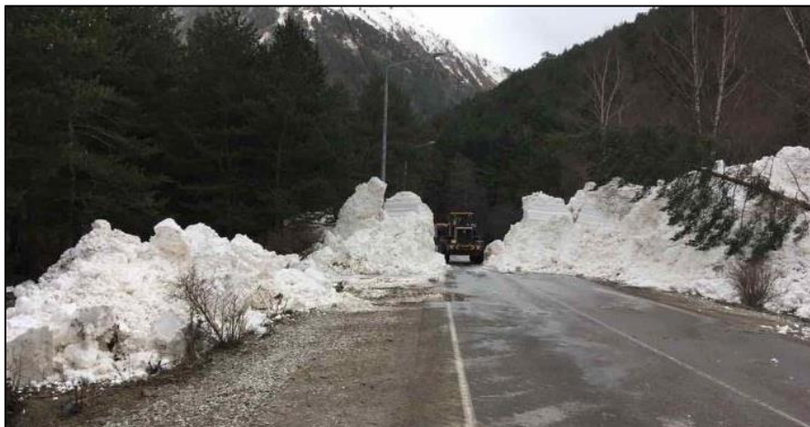
Рис. 6. Дорога, перекрытая лавиной возле населенного пункта Тегенекли
