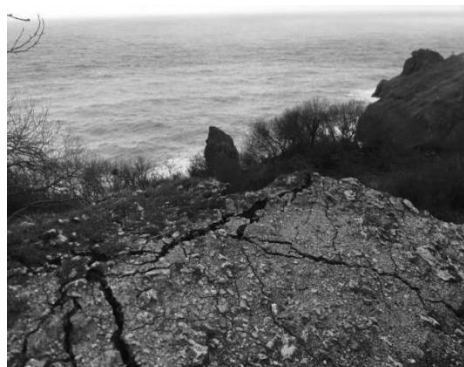
Рис. 4. Обвал грунта на м. Фиолент
