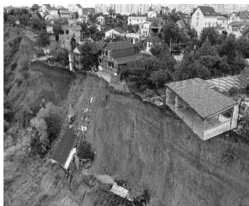
Рис. 2. Обвал грунта на территории
